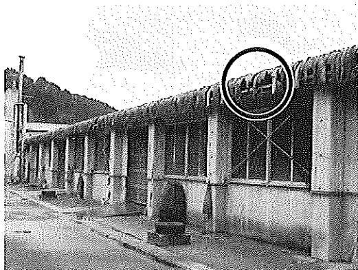
【写真 1. 建築物の外観】
