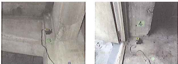
写真 1 常時微動測定の様子
