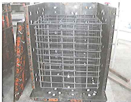
○ 写真 1000×1000×1000(mm)配筋側面
