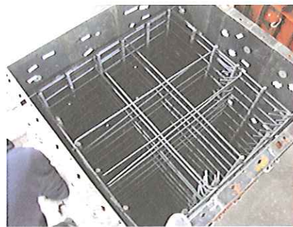
○ 写真 1000×1000×1000 (mm) 配筋上面
