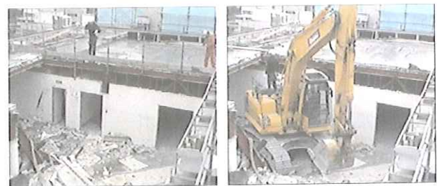
(a) 揚重前 (b) 揚重後
