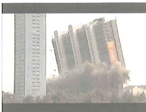
海外の発破解体工事
