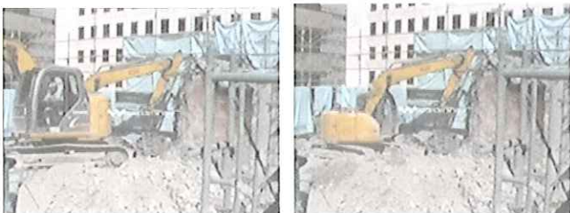
(a) 重機の移動中 (b) 重機の移動後
