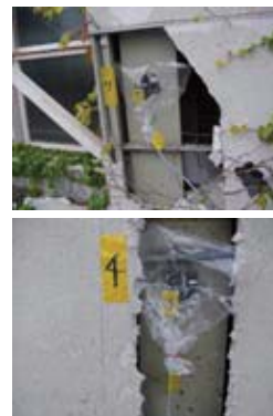
加速度センサーおよび 歪ゲージの設置位置
