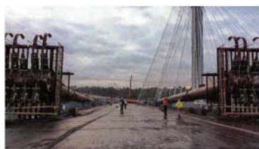
床版に置かれた仮設タワー
