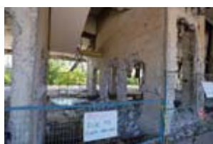
隔壁(EV用)の撤去
