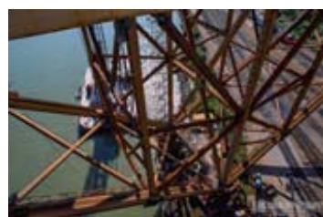
補強ブレースの設置状況
