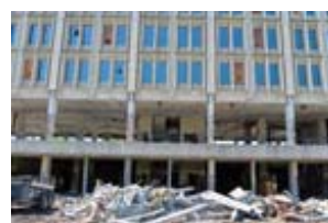
外壁撤去後の状況
