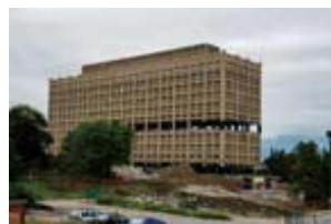
外壁撤去後の全景
