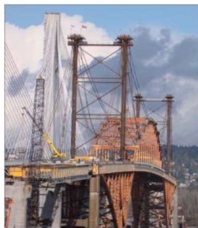
定位置に設置された仮設タワー
