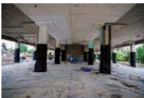
飛散防止用シートの施工
