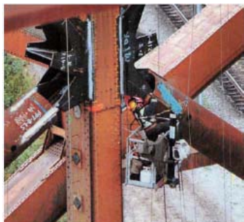
ブレースの溶接施工の状況
