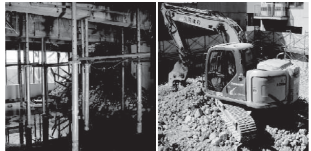
図1 本研究が想定とする階上解体工事（観察例） 左：重機作業階の直下階、右：重機作業階
