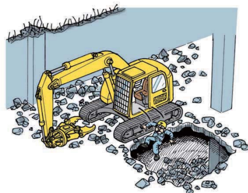
解体材を廃棄するために設けた開口部から墜落
