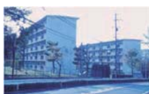
建替え前の建物の状況
