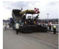
空港舗装の路盤に適用
