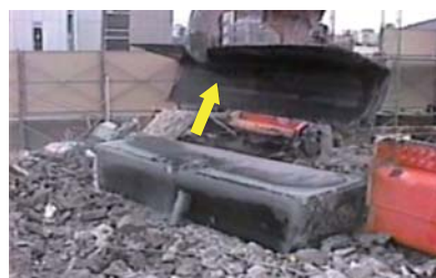
写真1 鋼管とコンクリートの分別作業の様子
