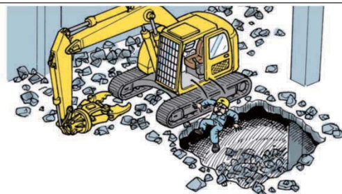
解体作業中の墜落
