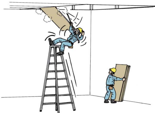
天井材をはがした反動で墜落
