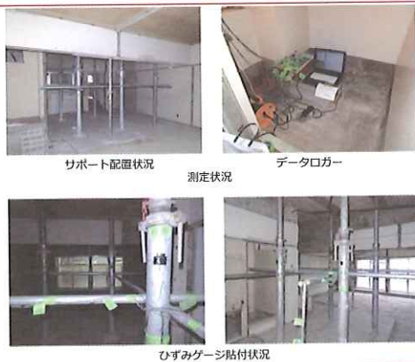
ひずみゲージ貼付状況
