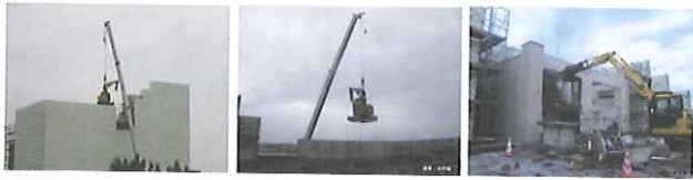
重機揚重の様子・解体工事
