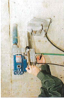
写真-1 コンクリートコアマシンによる φ50mmコア採取状況
