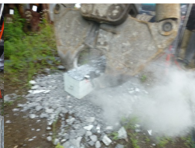
写真-6 コンクリート片の飛散
