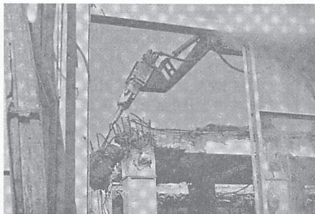
写真7 大型ブレーカによる解体
