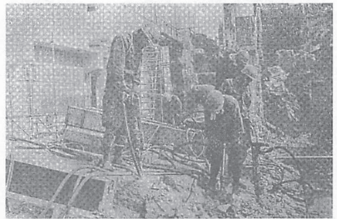
写真3 ハンドブレーカによる解体 (日本銀行本店1970年頃)
