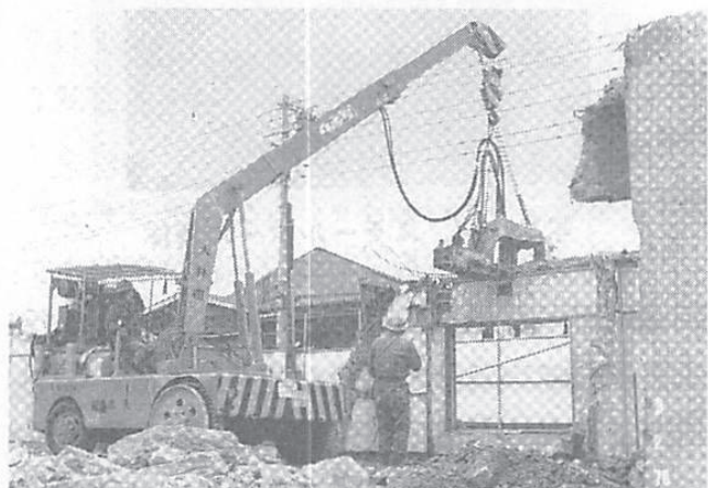
写真5 1978年頃の圧砕工法
