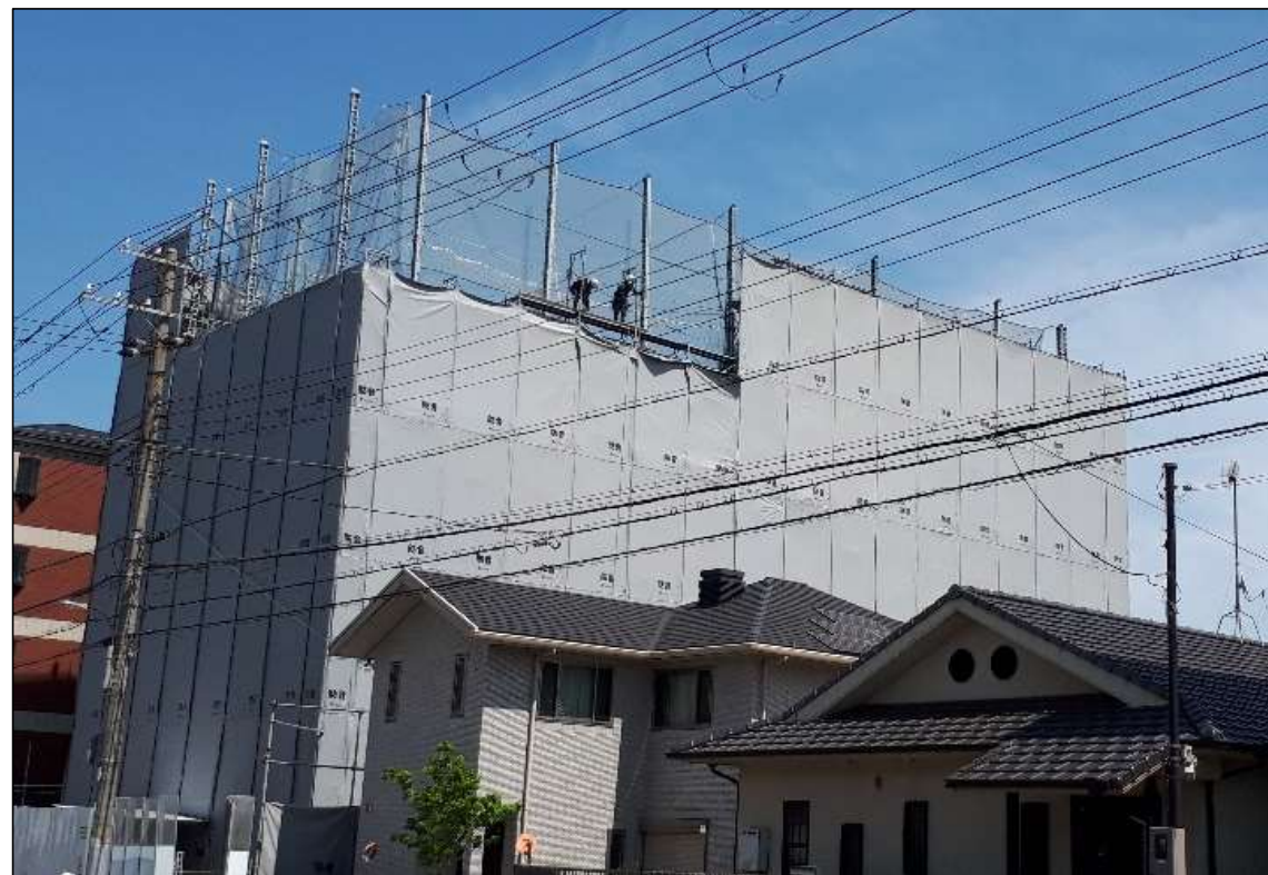
養生足場解体状況
