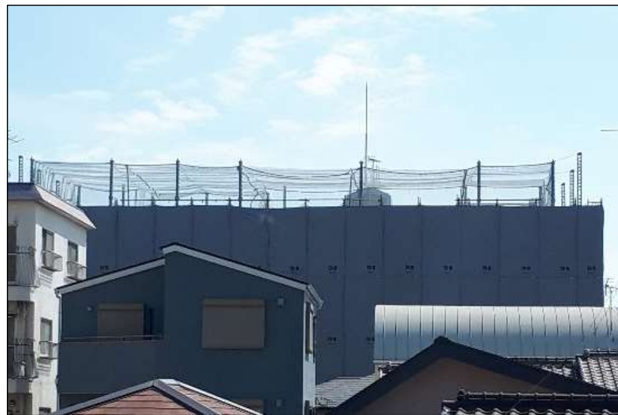
N - 1 階 へ 支 柱 ・ ネ ッ ト 盛 替 完 了
