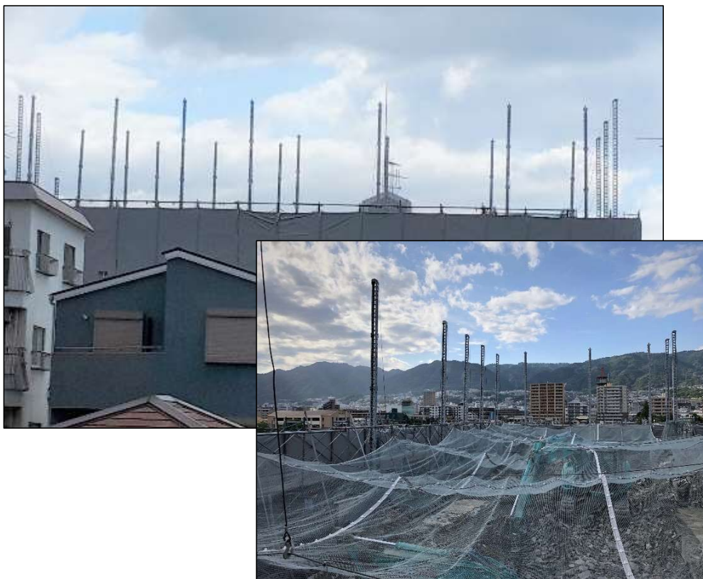
N 階 解 体 後 ネット 降 下 状 況
