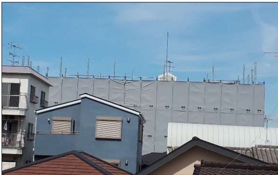
N - 1 階 へ 支 柱 盛 替 状 況
