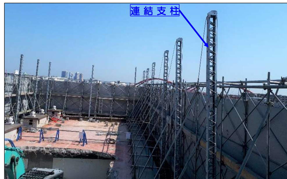
支柱取付完了状況
