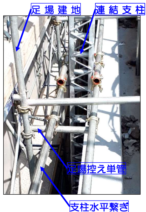
足場補強状況
