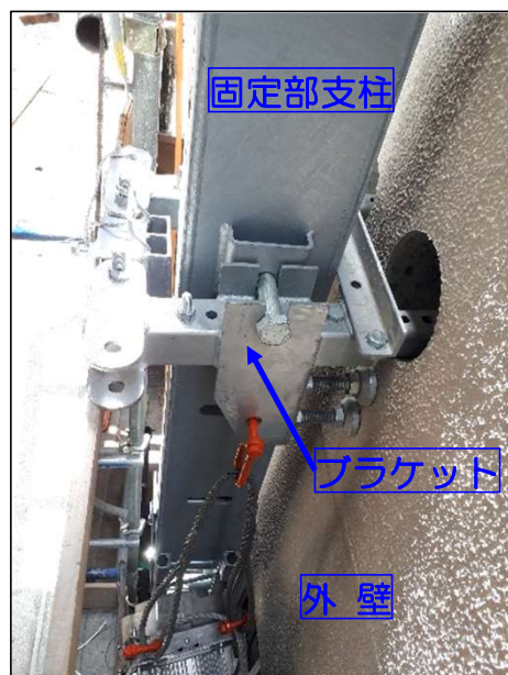
支柱固定状況
