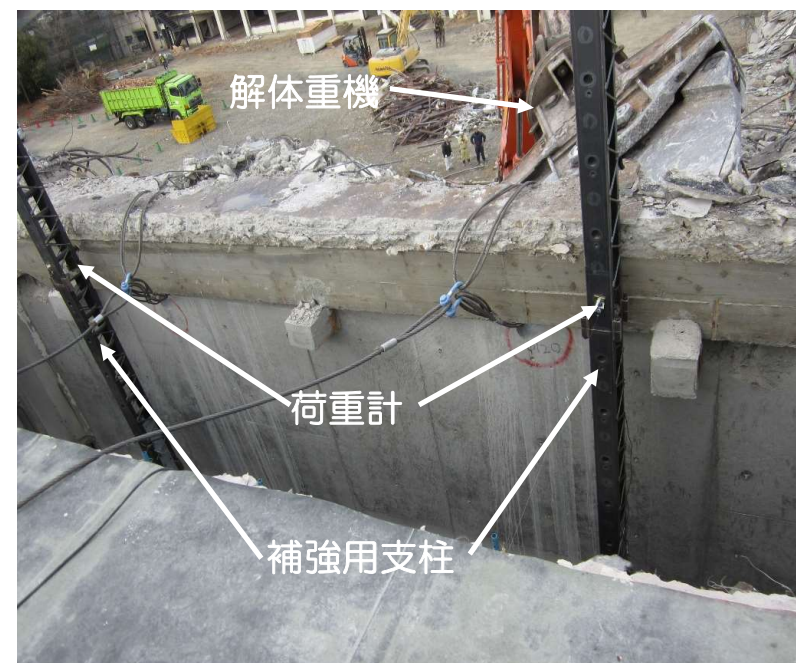
外壁解体現場実証試験
