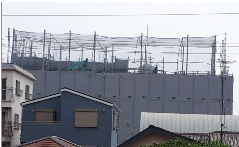
N 階 解 体 状 況
