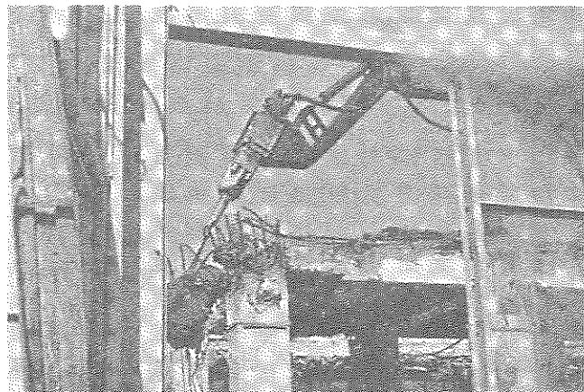
写真7 大型ブレーカによる解体
