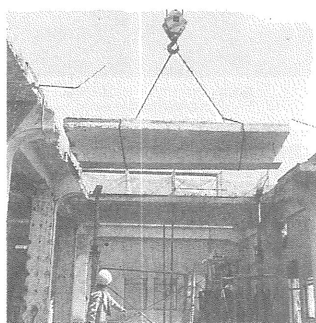
写真6 カッターによる部材解体
