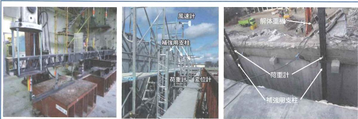
外壁及び養生足場の外部側への倒壊防止に有効であることを確認
