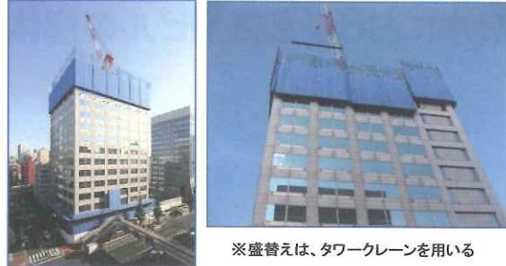
図-3 清水リバース・コンストラクション工法
