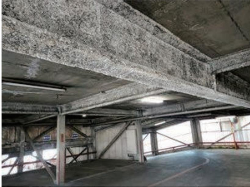
アスベストを含む吹付け材がむき出しとなっているOの第1駐車場の内部=2023年2月\*
