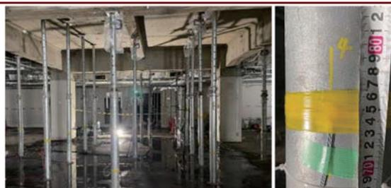
写真1 補強サポートおよびひずみゲージ設置状況
