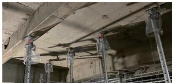
写真2 ロードセルの設置状況
